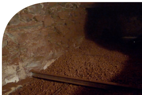
Taillet : Réhabilitation du bâtiment communal en matière d'économie d'énergie
