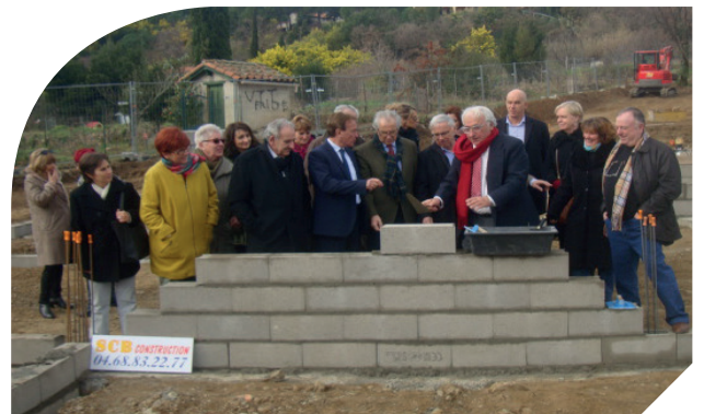
Pose de la Première pierre de la nouvelle Crèche et du RAM à Céret le 10 Février 2016
