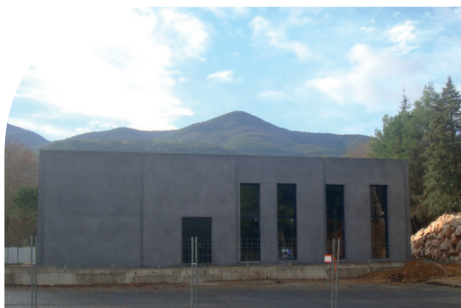
Céret : Réalisation de la halle des sports.
